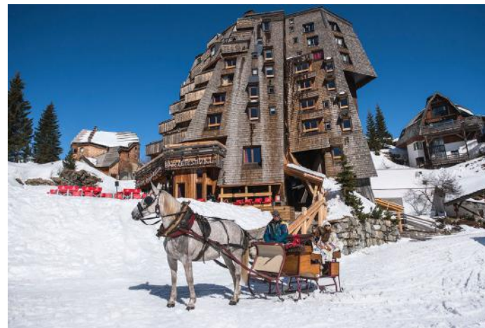
Fusion du mur et de la toiture pour éviter une accumulation de neige : réflexion sur la forme ?
